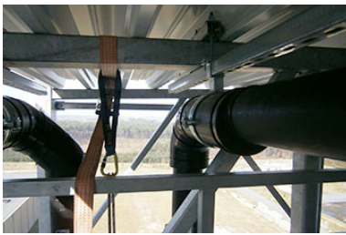
Nennweitenreduzierung der Falleitung.
