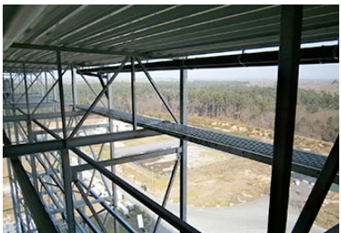
Montagebohlen erleichterten die Installation der Sammelleitungen.
