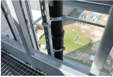
Baukörperbefestigung der Falleitung mit dem Montagesystem SitaDSS Rail und den Befestigungsschellen SitaDSS Down.
