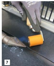
7 Abschließend kann einfach die Anschlussmanschette auf die vorhandene Abdichtungsbahn aufgeschweißt werden.
