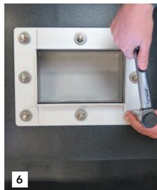
6 Das bekannte kreuzweise verschrauben mit dem Drehmomentschlüssel sichert die Dichtung zum Gullytopf.
