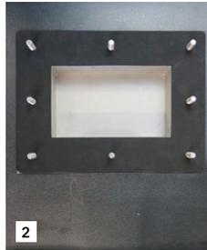
2 Nun wird die erste, untere Dichtmanschette aufgelegt.
