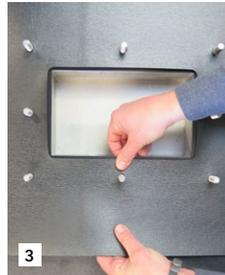
3 Danach folgt die Anschlussmanschette aus dem Material der Abdichtungsbahn.
