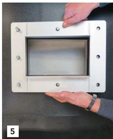
5 Der Losflansch mit eventuellem Anstau wird aufgesetzt.
