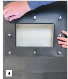
4 Als nächstes wird die zweite, obere Dichtmanschette aufgelegt.
