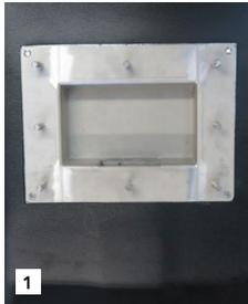
1 Die Abdichtungsbahn wird über den SitaTurbo gelegt und um den Festflansch herum ausgeschnitten.
