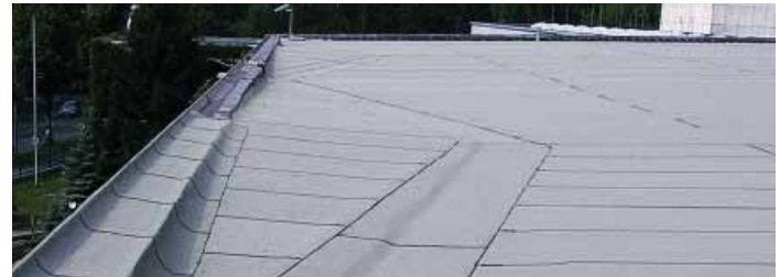
Fotos Deutsche Rockwool: Punktentwässerung führt den Niederschlag gezielt in Richtung Dachablauf
