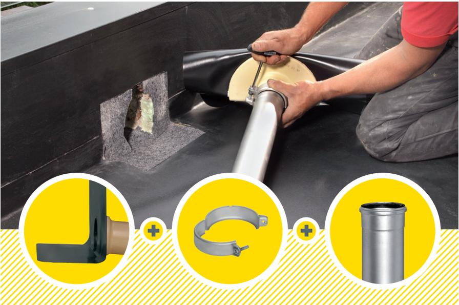
**Lösung:** Die SitaAttika Sicherungsschelle mit Dichtheitsgarantie
