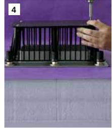
Abschließend werden der nach DIN EN 1253 erforderliche Kiesfang und eine Abdeckplatte montiert. Die Abdeckplatte verhindert, dass bei „Landregen“ der Notablauf Wasser abführt.
