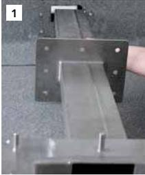
Die Position des Durchbruchs in der Attika erfolgt mit Hilfe des Dämmkörpers. Der Festflansch wird an der Attika befestigt, die Abdichtungsbahn wird regelkonform verlegt und mit dem SitaTurbo eingeflanscht.
