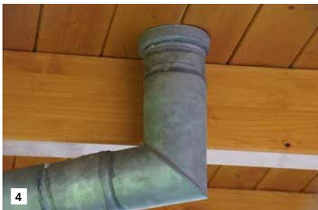
Die Untersicht kann durch Einbau eines SitaCarport mit üblichem Rohrsystem verkleidet werden. Einfach das Standrohr über den Stützen schieben und die passende Verblendkappe darüber ziehen. Damit ist sowohl eine sichere Entwässerung hergestellt, als auch eine einwandfreie Ansicht des Carports.
