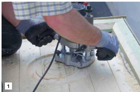
Mit einer Oberfräse die erforderliche Aussparung in die Holzdeckenkonstruktion fräsen und den Durchbruch bohren.
