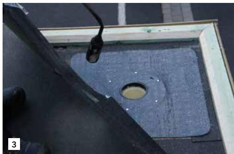
Abdichtungsbahn ausschneiden und passend auf die Bitumenmanschette aufschweißen oder bei alternativen Abdichtungsbahnen auf der Sondermanschette nach Herstellerangaben befestigen.
