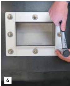
6 Serrage en croix des boulons au clé dynamométrique pour une compression uniforme du joint.
