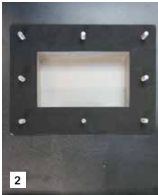
2 Application du premier joint d'étanchéité (inférieur).
