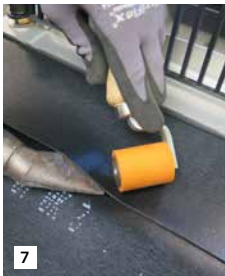
7 Soudage ou collage de la manchette de raccord sur la membrane existante.
