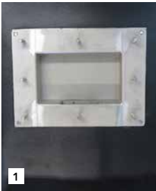
1 La membrane d'étanchéité est posée sur le SitaTurbo et découpée autour de la bride fixe.
