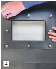
4 Pose du second joint d'étanchéité (supérieur).
