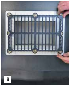
8 Après un second resserrage des boulons, installation du grillage pare feuilles SitaTurbo comme dernière étape.
