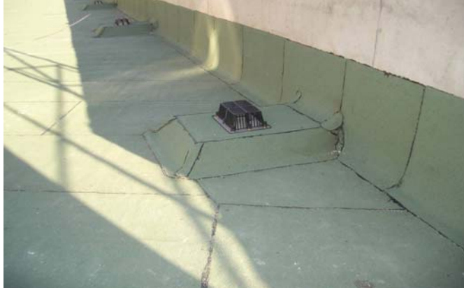
Bild 1: „Warmdach“ im Bereich des Notentwässers (SitaTurbo)
